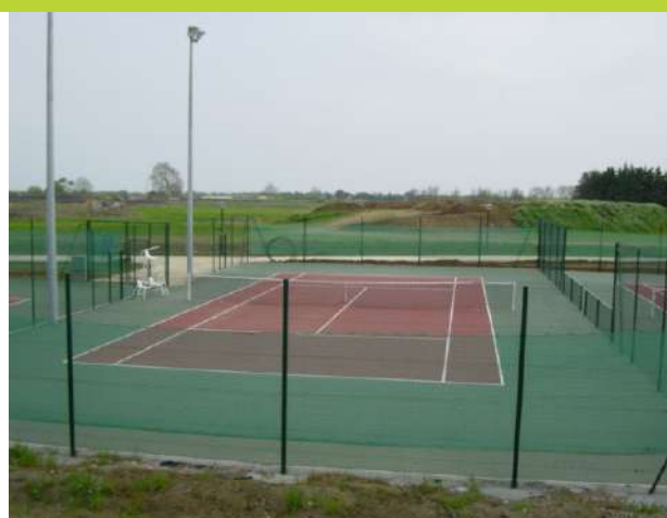
Grillage simple torsion vert avec surbaisse et portillon
