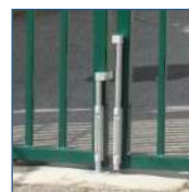
Second arrêt en ouverture (baïonnette + douille)
