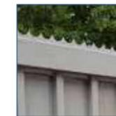
Lisse dentée rivetée sur vantail
