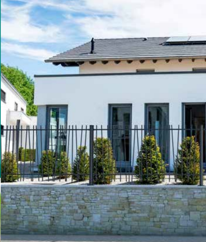
Conformité écartement barreaux maximum 110 mm
