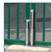
Second arrêt en ouverture (baïonnette + douille)
