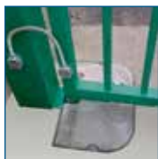
Moteur encastré au sol
